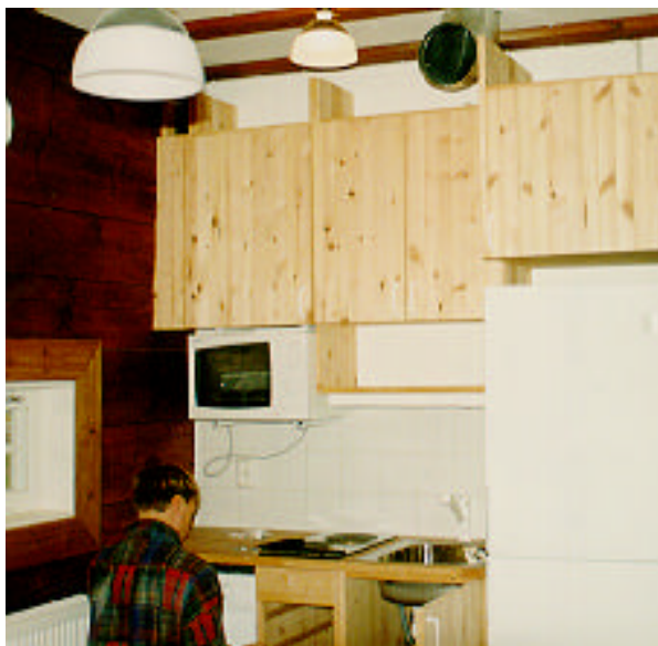
Fig 4. Diskbänken - av återvunnet virke
