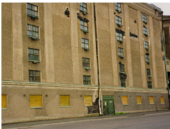
Fig 1. Bild från gamla tobakslagret vid gasklockan - Göteborg
