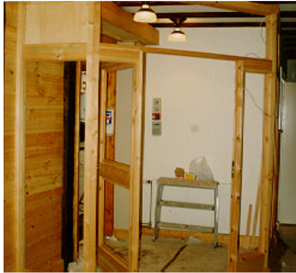
Fig 2. Nyttillverkat vindfång av återvunnet virke
